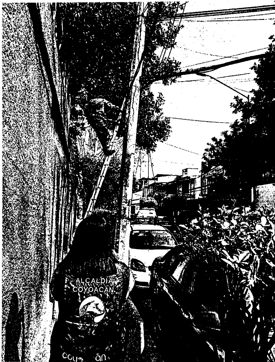
Imagen 2. Jornada de retiro de cableado en desuso (El Rosedal)
