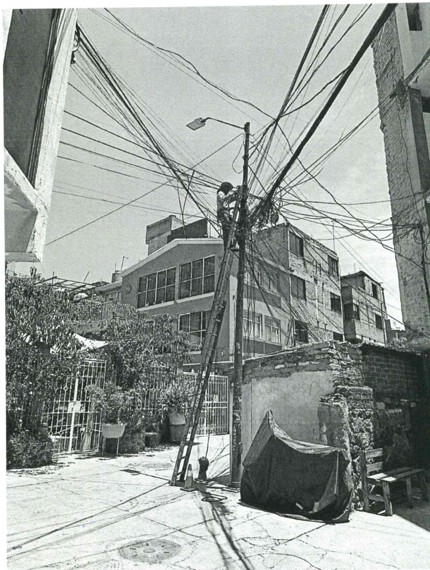
Imagen 1. Retiro de cable en desuso – Col. Pueblo de los Reyes
