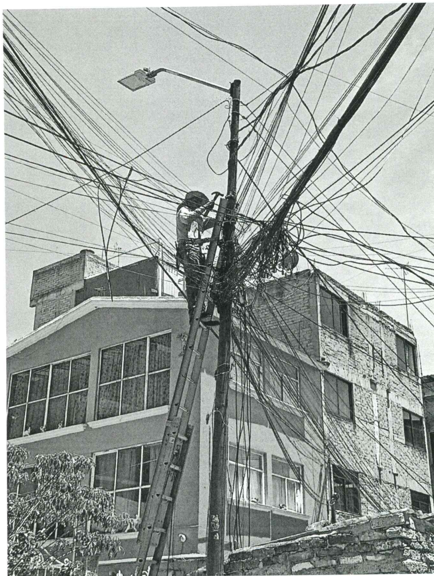
Imagen 2. Retiro de cable en desuso – Col. Pueblo de los Reyes
