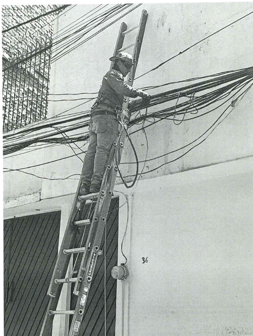
Imagen 3. Retiro de cable en desuso – Col. Pueblo de los Reyes
